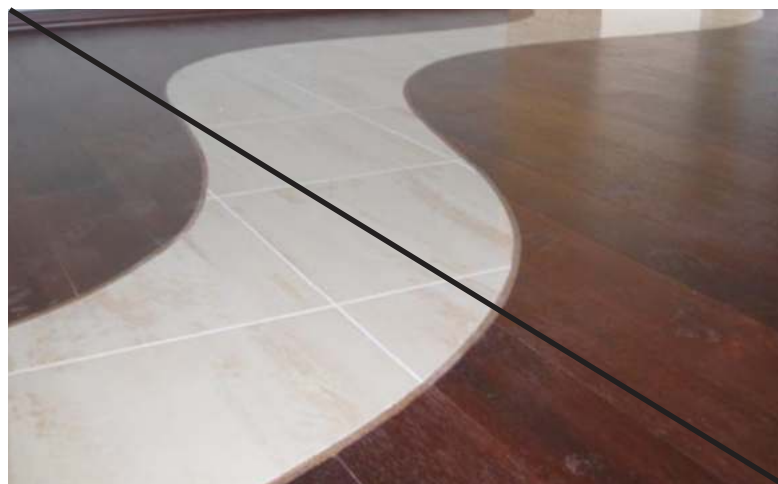
Плохо Узорные стыки из разных материалов
